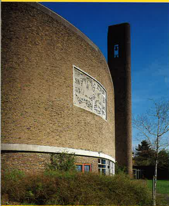
GKN Opstandingskerk te Arnhem, architect Rotshuizen en Dekker, 1962 (foto: Kim Zwarts).
